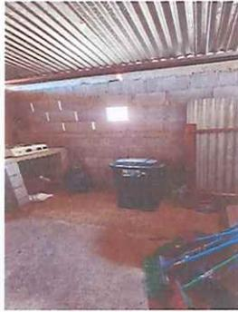
Foto1: Sustitución de lámina, por lámina troquelada aluzinc calibre 26 y estructura en cocina
