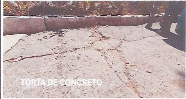
Foto 4: Reparación de planchas de concreto de patio
