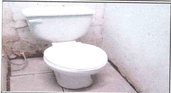
Foto 2: sustitucion de sanitarios
