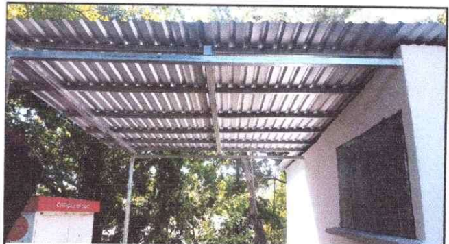
Foto 4: Estructura techo de la ampliacion de la cocina
