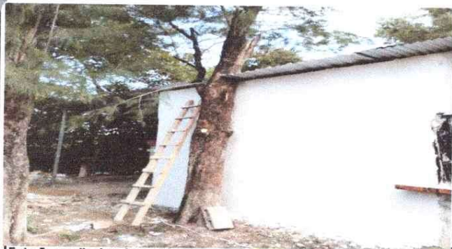
Foto 5: ampliacion de cocina
