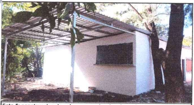
Foto 5: construccion de galera en ampleacion de cocina
