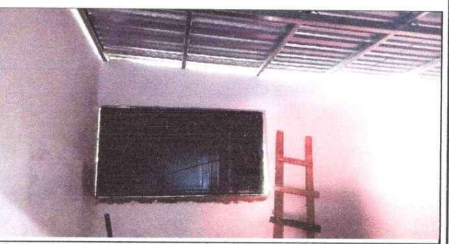
Foto 6: Instalacion de Ventana en Cocina
