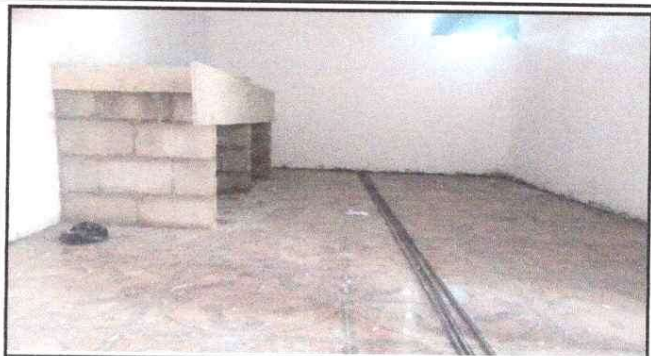
Foto 2: Contruccion de Polleton
