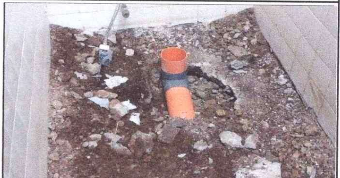
Foto 2: instalacion de servicios sanitarios
