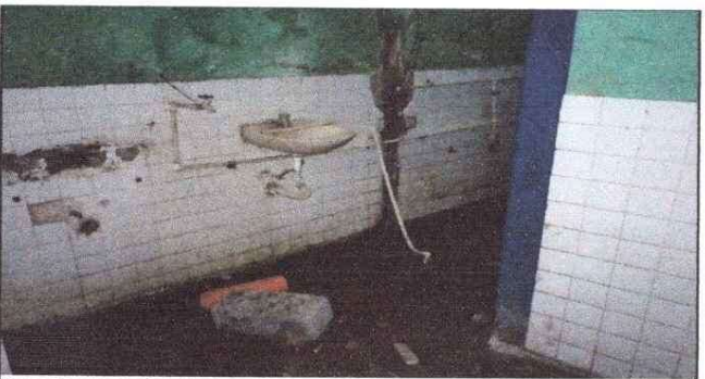
Foto 5: colocacion de drenajes
