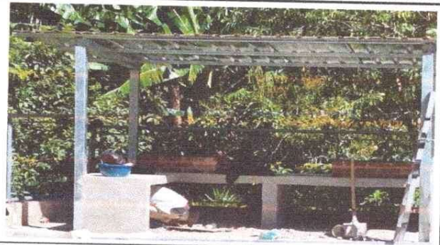
Foto 2: Construcción de galera y poyeton para cocina exterior
