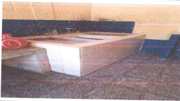
Foto 3: Construcción de pila de dos lavaderos mas azulejo
