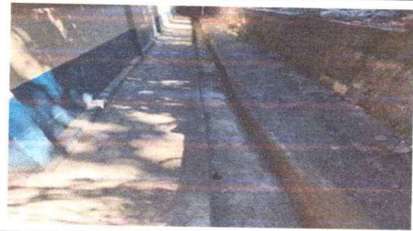
Foto 4: Construcción de banqueta con cuneta
