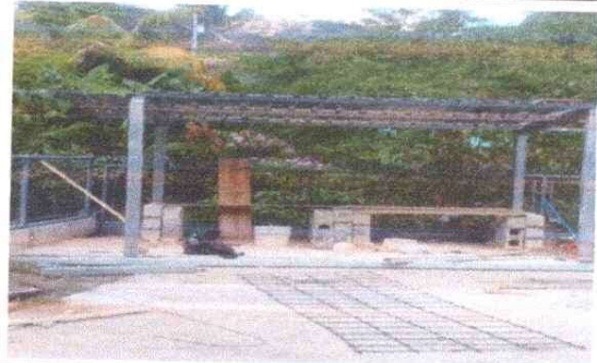
Foto 2: Construcción de galera y poyeton para cocina exterior
