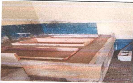
Foto 3: Construcción de pila de dos lavaderos mas azulejo
