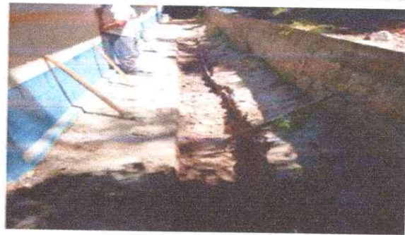
Foto 4: Construcción de banqueta con cuneta
