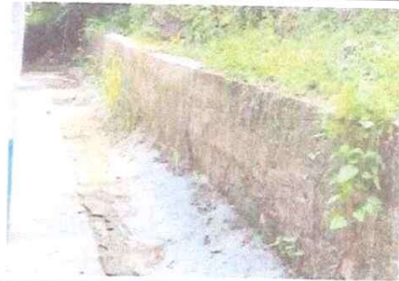
Foto 4: Construcción de banqueta con cuneta
