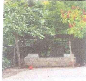
Foto 2: Construcción de galera y poyeton para cocina exterior
