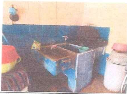
Foto 3: Construcción de pila de dos lavaderos mas azulejo
