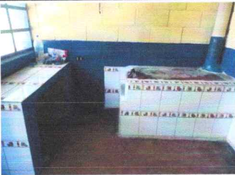
Foto 5: SUSTITUCIÓN DE ESTUFA RURAL CON CHIMENEA, PLANCHA DE METAL E INSTALACIÓN DE AZULEJO EN ÁREA DE COCINA
