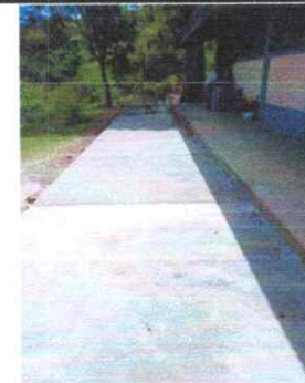
Foto 6: REPARACIÓN DE PISO DE TORTA DE CONCRETO EN PATIO
