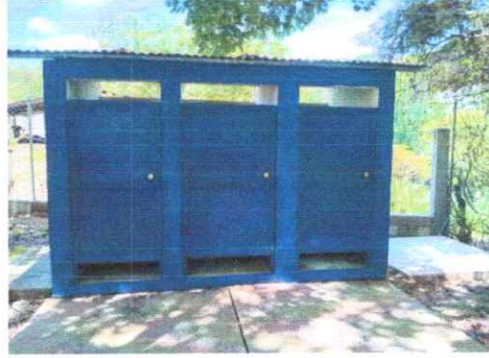
Foto 4: REPARACIÓN DE PUERTAS METÁLICAS EN SERVICIOS SANITARIOS Y MODULO DE AULAS
