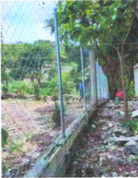
Foto 1: REPARACIÓN DE MURO PERIMETRAL DE BLOCK CON TUBO HG Y MALLA GALVANIZADA, SOLERAS INTERMEDIAS Y COLUMNAS
