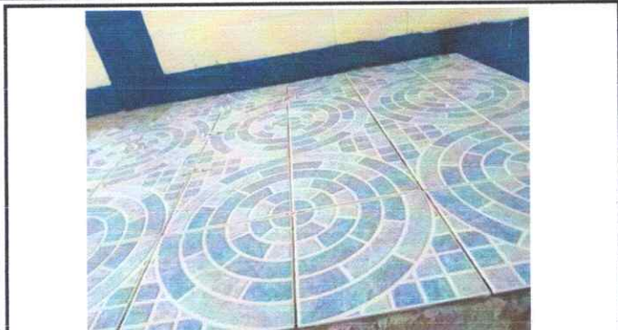
Foto 7: SUSTITUCIÓN DE TORTA DE CONCRETO POR PISO CERÁMICO
