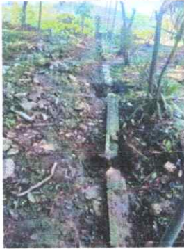
Foto 1: REPARACIÓN DE MURO PERIMETRAL DE BLOCK CON TUBO HG Y MALLA GALVANIZADA, SOLERAS INTERMEDIAS Y COLUMNAS
