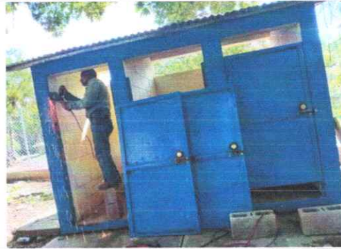
Foto 4: REPARACIÓN DE PUERTAS METÁLICAS EN SERVICIOS SANITARIOS Y MÓDULO DE AULAS
