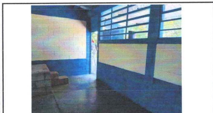
Foto 9: SUSTITUCIÓN DE VIDRIOS
