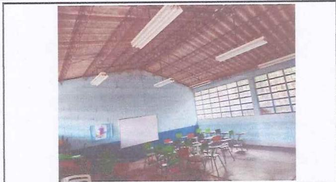
Foto 2: SUSTITUCIÓN TECHO CON DURALITA Y ESTRUCTURA DE METAL POR LÁMINA TROQUELADA EN MODULO DE AULAS
