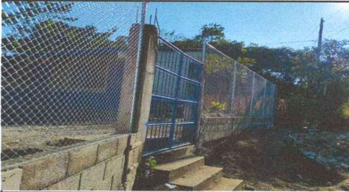
Foto 1: FINALIZACIÓN DE MURO PERIMETRAL
