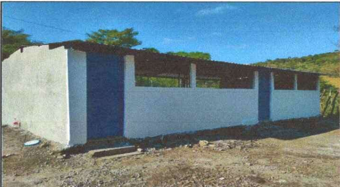
Foto 3: FINALIZACIÓN DE REPELLO DE PARED DE COCINA
