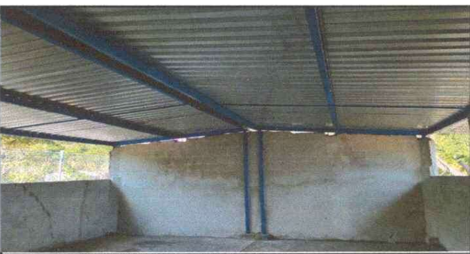
Foto 5: FINALIZACIÓN DE TECHO EN COCINA
