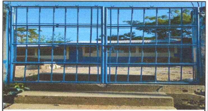
Foto 2: FINALIZACIÓN DE REPARACIÓN DE PORTÓN
