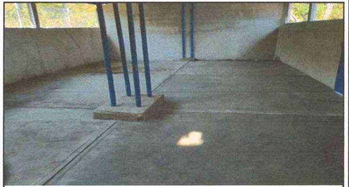
Foto 4: FINALIZACIÓN DE TORTA DE CEMENTO EN COCINA
