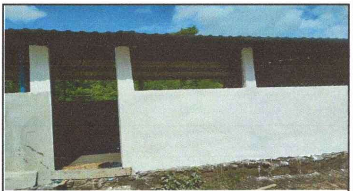
Repello y colocación de puertas
