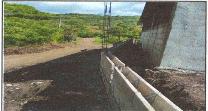
Reparación de muro perimetral
