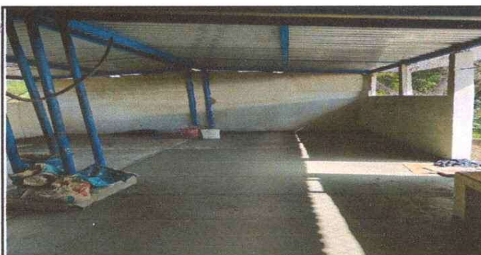
Reparación y alizado de torta de cemento
