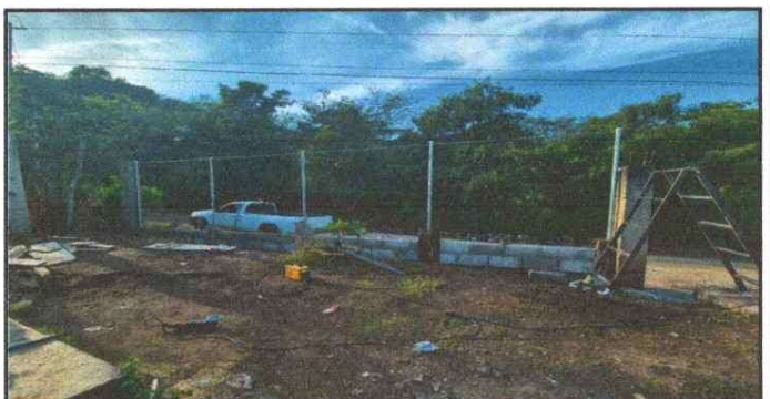
Colocación de malla metálica
