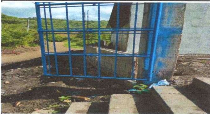
Reparación y remozamiento de portón
