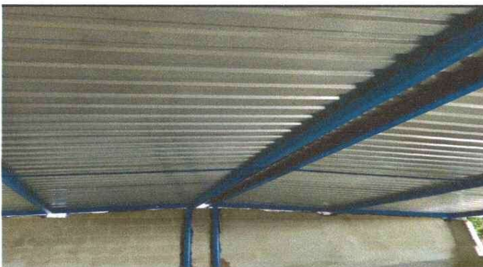
Reparación de techo de cocina
