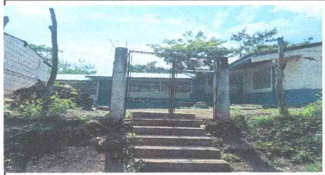
Foto 2: Mejoramiento de Portón
