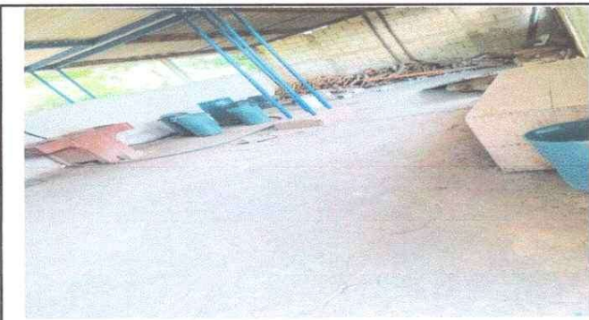
Foto 3: Mejoramiento de piso de cocina
