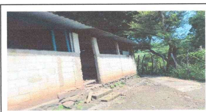
Foto 5: Mejoramiento paredes de cocina
