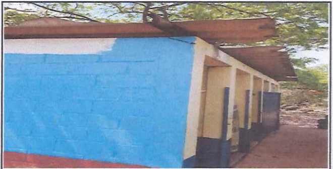
Foto 4: Mojaramiento de sanitarios, cambio de techo y colocación de puertas.
