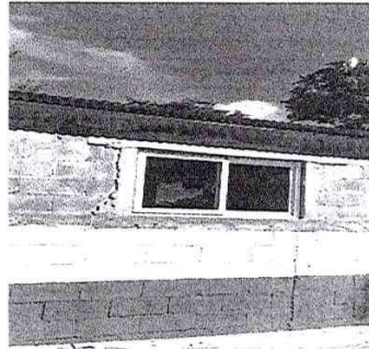
Foto 3: COLOCACIÓN DE VENTANA CORREDIZA
