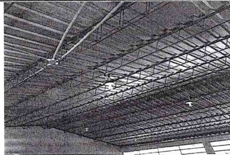
Foto 6: REPARACIÓN DEL SISTEMA ELÉCTRICO
