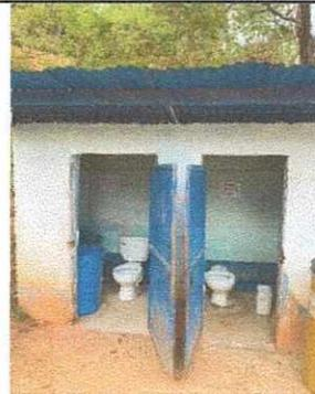
Foto 6: Remozamiento de baños con ampliación de muros, instalación de inodoros, azulejo, piso cerámico.
