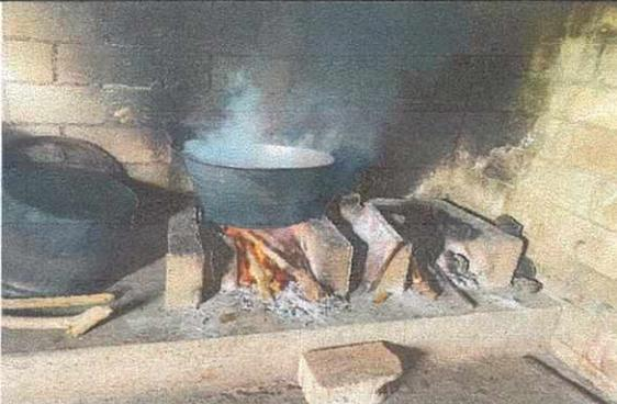
Foto 3: Suministro e instalación de estufa rural completa con chimenea y parrilla de metal.
