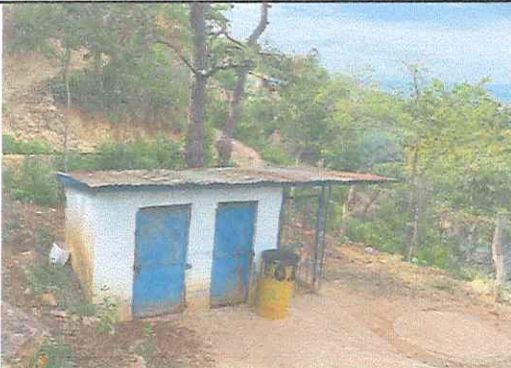
Foto 9: Susutitución de techo en módulo de baños.
