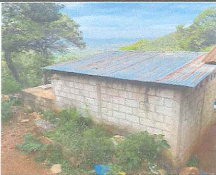
Foto 5: Sustitución de techo para cocina.
