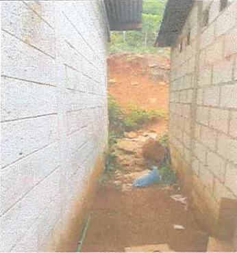
Foto 1: Ampliación de paredes o muros de la cocina
