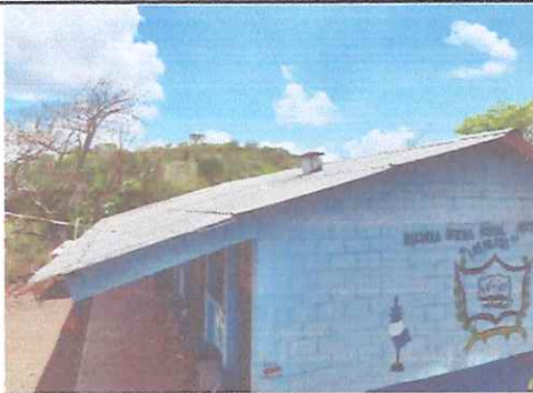
Foto 1: SUSTITUCIÓN TECHO CON DURALITA Y ESTRUCTURA DE METAL POR LÁMINA TROQUELADA EN MODULO DE AULAS
