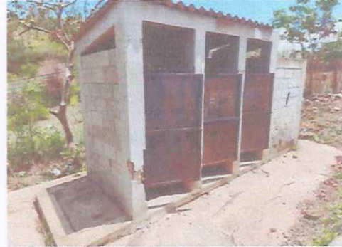
Foto 4: SUSTITUCIÓN DE TECHO CON DURALITA Y POR LÁMINA TROQUELADA, MEJORAMIENTO DE FOSA SEPTICA, PAREDES Y PUERTAS METALICAS E INSTALACIÓN DE TUBERIA PARA DRENAJE EN SANITARIOS
