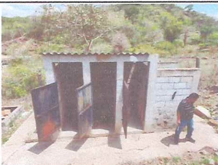
Foto 5: SUSTITUCIÓN DE LETRINAS POR BAÑOS LAVABLES Y SUSTITUCIÓN DE MINGITORIO
