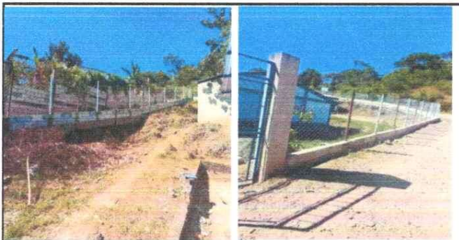
Foto 5: MEJORAMIENTO DE MURO PERIMETRAL DE BLOCK CON TUBO HB MALLA Y SOLERAS INTERMEDIAS
