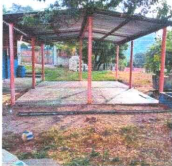
Foto 9: REPARACIÓN DE PISO DE TORTA DE CONCRETO
