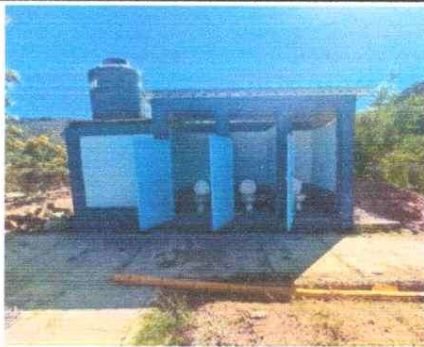
Foto 3: SUSTITUCIÓN DE TECHO, SUSTITUCIÓN DE LETRINAS POR BAÑOS LAVABLES Y SUS ACCESORIOS, MEJORAMIENTO DE FOSA SEPTICA Y DRENAJES EN SERVICIOS SANITARIOS
