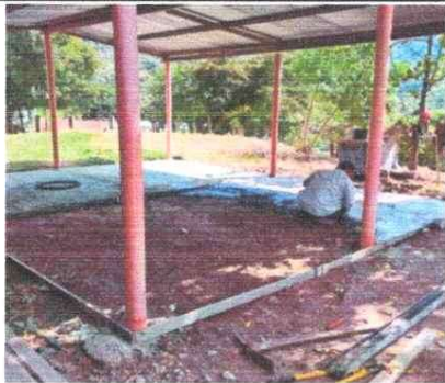
Foto 9: REPARACIÓN DE PISO DE TORTA DE CONCRETO
