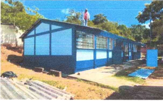
Foto1: SUSTITUCIÓN DE TECHO DE DURALITA Y TECHO DE LAMINA ACANADALADA CON ESTRUCTURA DE METAL POR LAMINA TROQUELADA CALIBRE 26
