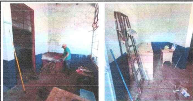
Foto 6: MEJORAMIENTO DEL AREA DE COCINA, SUSTITUCIÓN DE ESTUFA RURAL CON CHIMENEA, PLANCHA DE METAL E INSTALACIÓN DE AZULEJO Y MEJORAMIENTO DE MUEBLE DE COCINA
