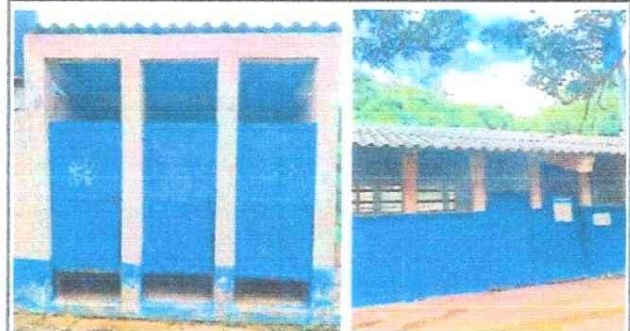
Foto 4: REPARACIÓN DE PUERTAS EN SERVICIOS SANITARIOS Y MODULO DE AULAS
