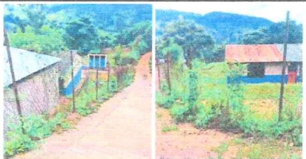
Foto 5: REPARACIÓN DE MURO PERIMETRAL DE BLOCK CON TUBO HB, MALLA GALVANIZADA Y SOLERAS INTERMEDIAS
