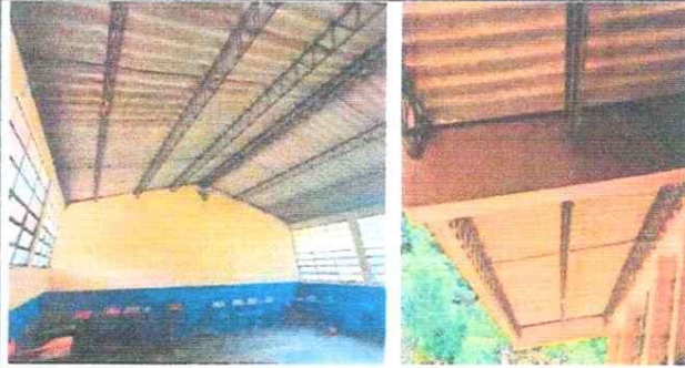
Foto 1: SUSTITUCIÓN DE TECHO DE DURALITA Y TECHO DE LAMINA ACANALADA CON ESTRUCTURA DE METAL POR LÁMINA TROQUELADA CALIBRE 26
