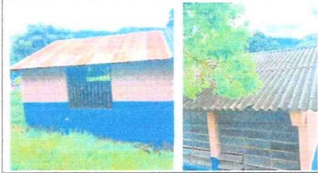
Foto 7: MANTENIMIENTO A ESTRUCTURA DE METAL EN VENTA MAS INSTALACIÓN DE VIDRIOS
