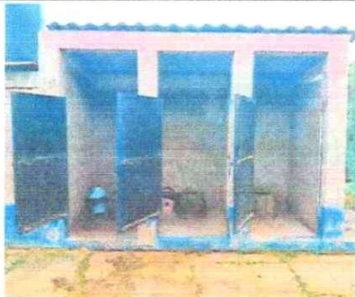
Foto 3: SUSTITUCIÓN DE TECHO DE DURALITA POR LAMINA TROQUELADA, SUSTITUCIÓN DE LETRINAS POR BAÑOS LAVABLES Y SUS ACCESORIOS, MEJORAMIENTO DE FOSA SEPTICA Y DRENAJES EN SERVICIOS SANITARIOS
