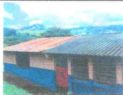
Foto 2: SUSTITUCIÓN DE TECHO DE DURALITA Y TECHO DE LAMINA CON ESTRUCTURA DE METAL POR LÁMINA TROQUELADA CALIBRE 26
