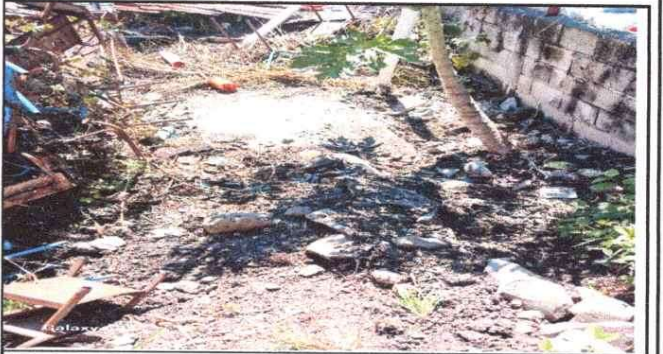
Foto 4: Reparacion de Drenajes
