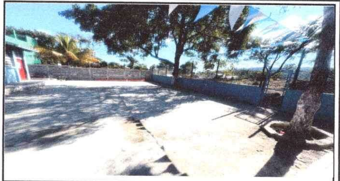
Foto 2: Mejoramiento de Torta de Concreto
