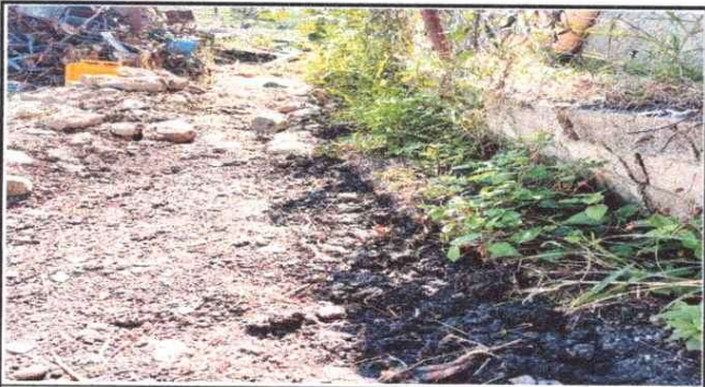
Foto 3: Reparacion de Drenajes
