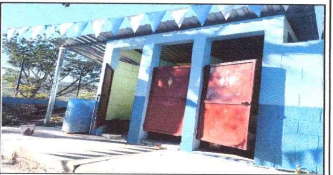
Foto 6: Cubierta de Lamina
