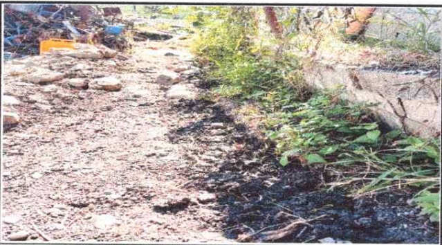
Foto 3: Reparacion de Drenajes
