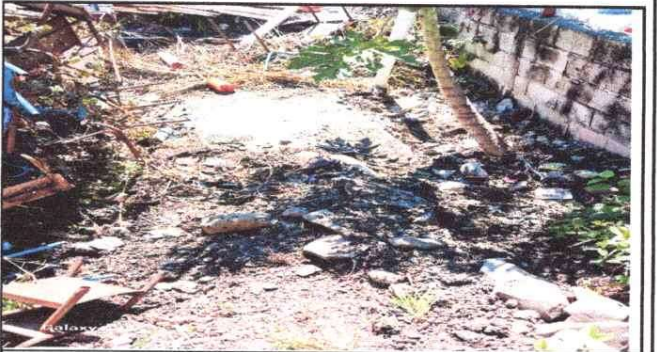
Foto 4: Reparacion de Drenajes
