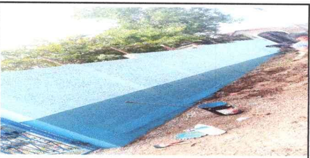
Foto 5: Pintura Muro Perimetral Frontal
