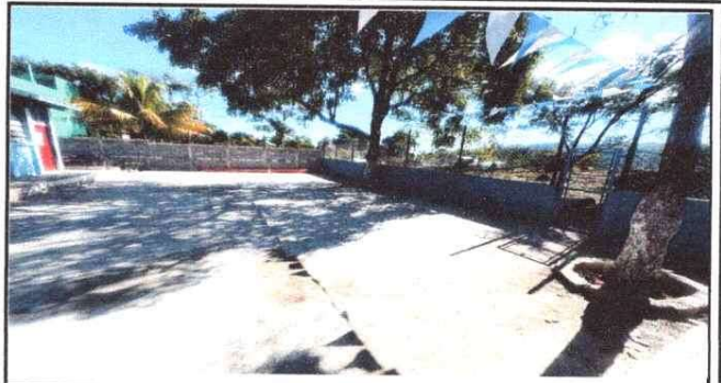
Foto 2: Mejoramiento de Torta de Concreto
