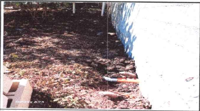
Foto 3: Reparación de Drenajes
