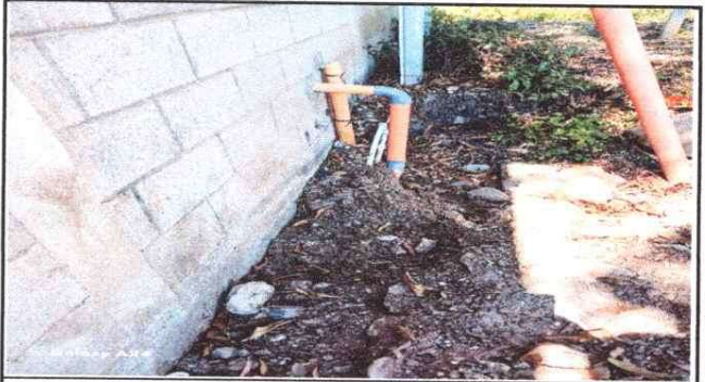
Foto 4: Reparación de Drenajes
