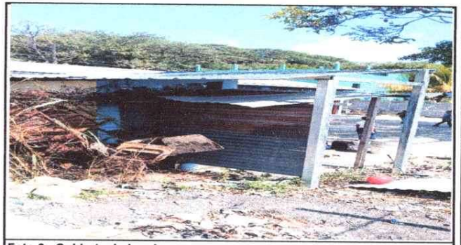
Foto 6: Cubierta de Lamina
