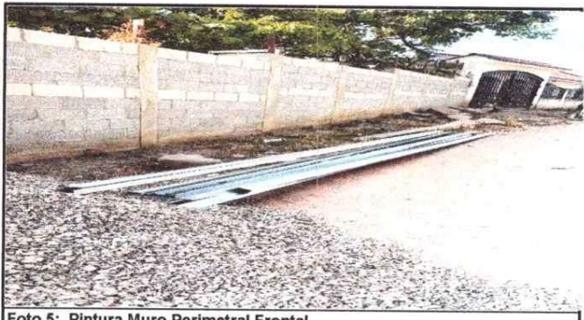
Foto 5: Pintura Muro Perimetral Frontal
