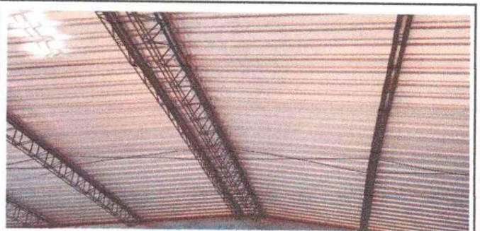
Foto 4: Mejoramiento y colocacion de techado en aula, modulo 1
