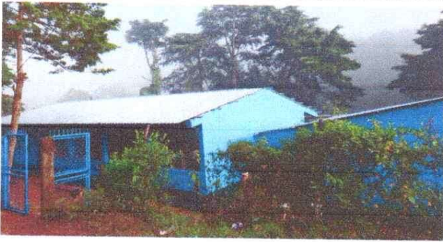
Foto 1: Mejoramiento y colocacion de techado en aula, modulo 2
