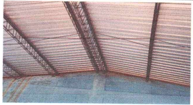
Foto 2: Mejoramiento y colocacion de techado en aula, modulo 2
