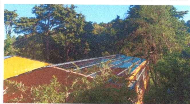
Foto 4: Mejoramiento y colocacion de techado en aula, modulo 1
