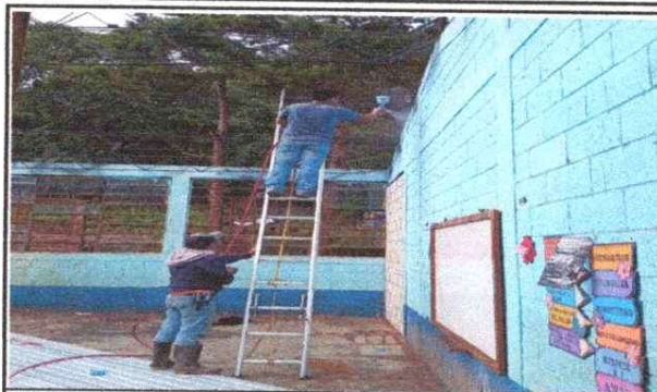
Foto 2: Mejoramiento y colocacion de techado en aula, modulo 2
