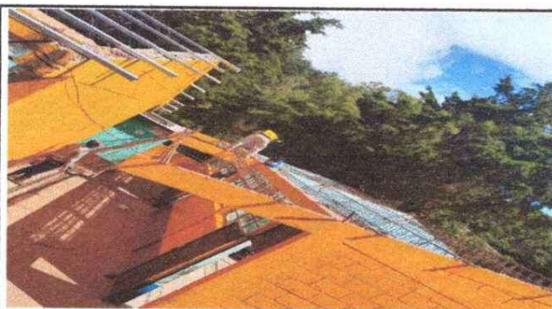
Foto 3: Mejoramiento y colocacion de techado en aula, modulo 1
