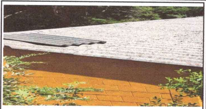
Foto 2: Mejoramiento y colocacion de techado en aula, modulo 1
