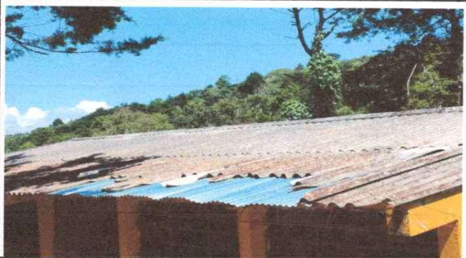
Foto 3: Mejoramiento y colocacion de techado en aula, modulo 2
