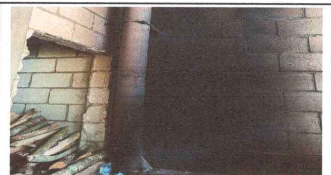
Foto 6: Mejoramiento en cocina.
