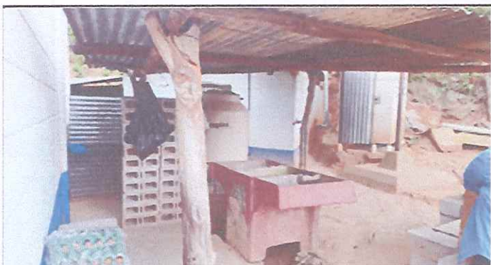
Foto 3. Mejoramiento de galera para patio de cocina
