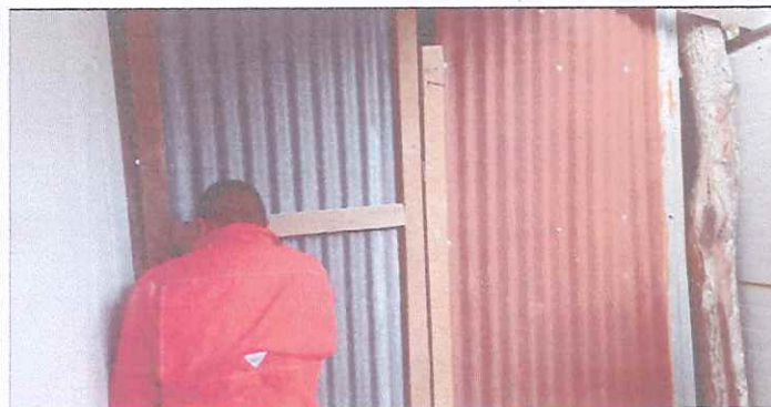
Foto 9. Mejoramiento de paredes y puertas de 2 aulas
