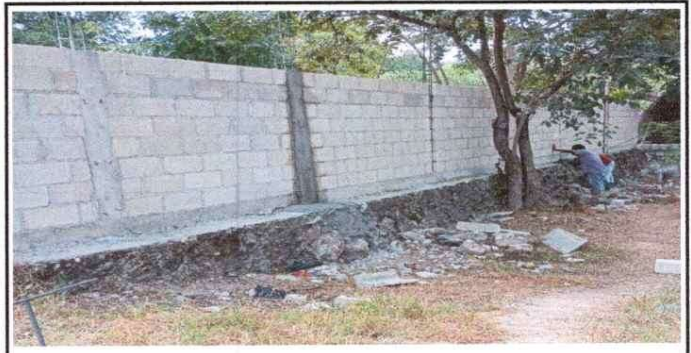
Foto 6: Mejoramiento de tapial de maya a tapial de mamposteria
