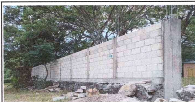
Foto 5: Mejoramiento de tapial de maya a tapial de mamposteria
