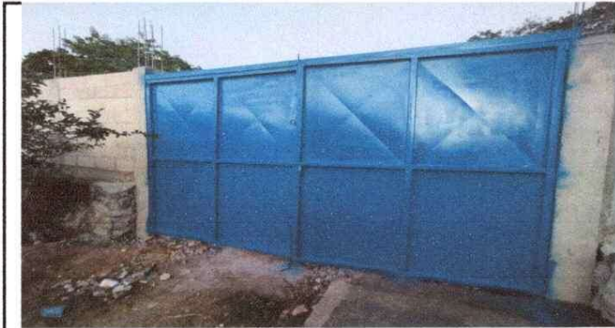
Foto1: porton de metal
