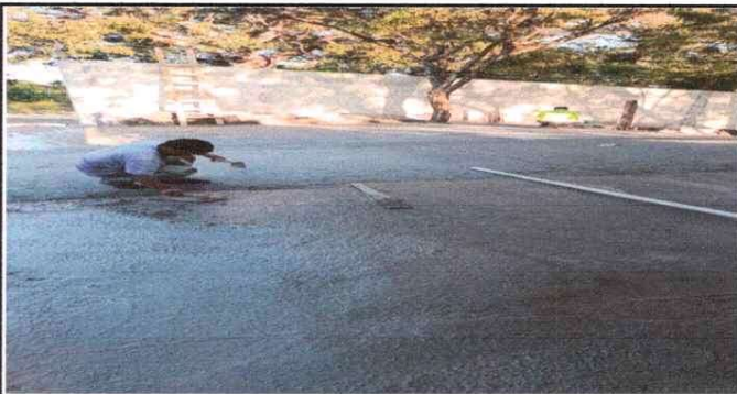
Foto 3: Ampliacion de tora
