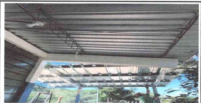
Foto 4: Remozamiento de techo
