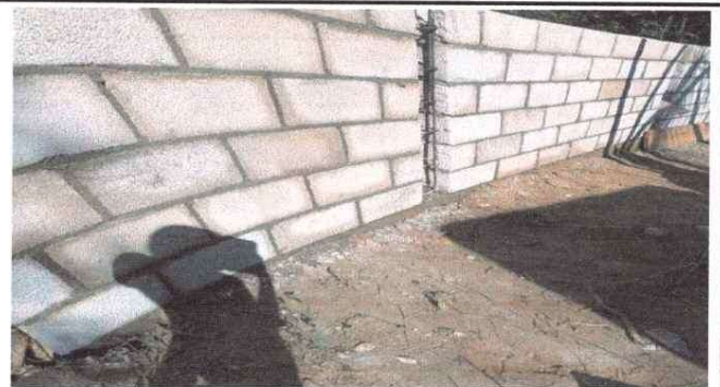
Foto 2: Remozamiento de muro
