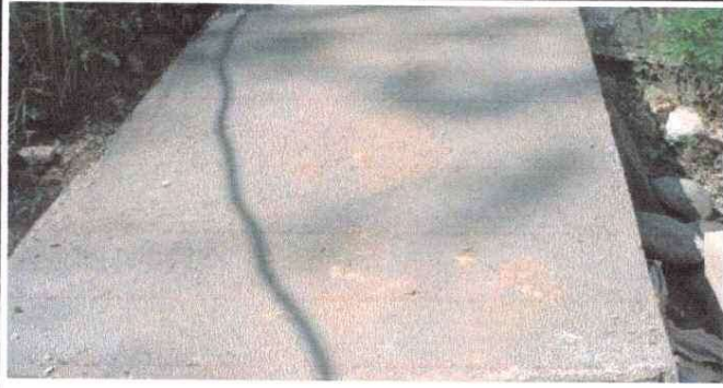
Foto 1: Remozamiento de losa
