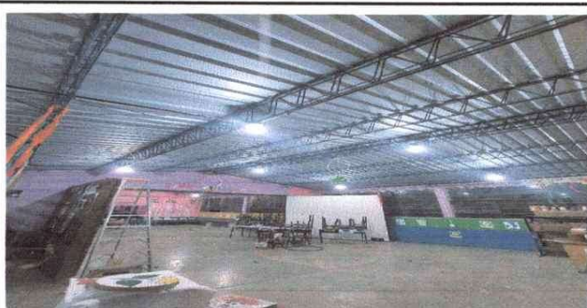
Foto 5: Remozamiento sistema eléctrico
