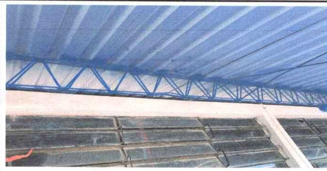
Foto 3: Remozamiento de estructura
