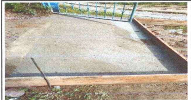
Foto 4: Mejoramiento losa de porton
