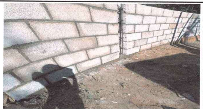
Foto 2: Remozamiento de muro
