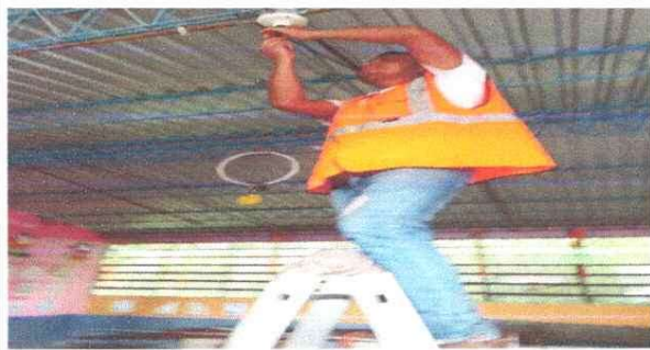
Foto 1: Mejoramiento sistema electrico
