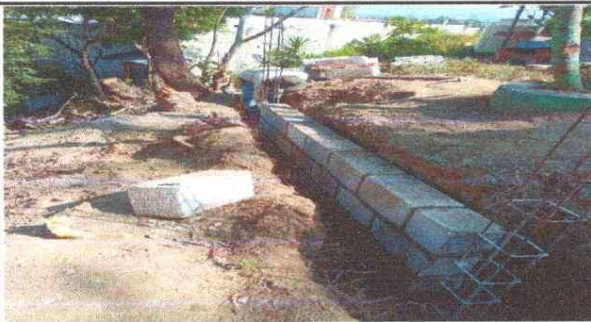
Foto 3: Mejoramiento muro perimetral
