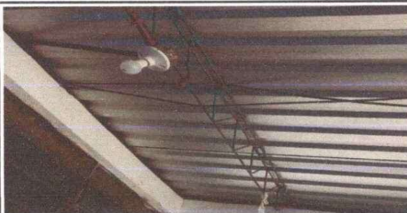
Foto 5: Mejoramiento sistema electrico
