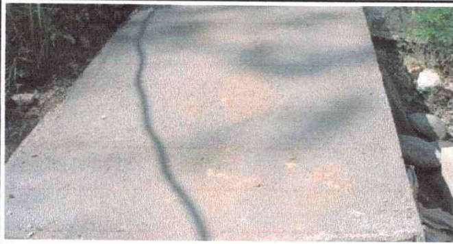
Foto 1: Remozamiento de losa
