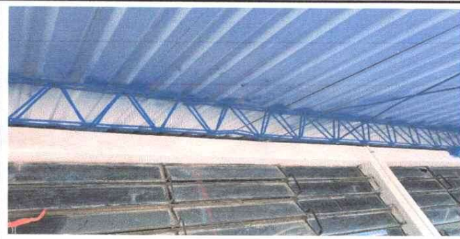
Foto 3: Remozamiento de estructura
