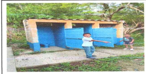
Foto 6: Mejoramiento de baños
