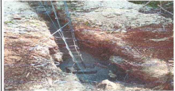
Foto 2: Mejoramiento de muro perimetral
