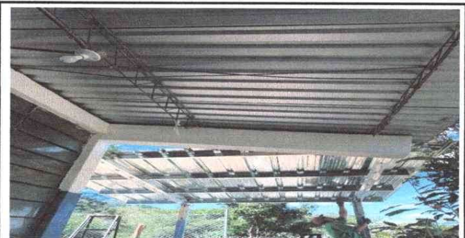
Foto 4: Remozamiento de techo
