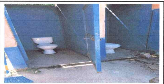
Foto 6: Remozamiento de baños
