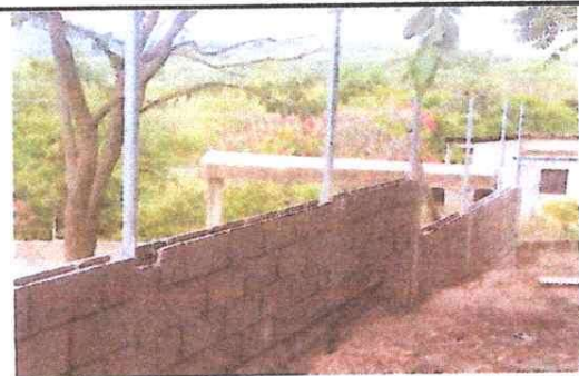
Foto 6: Levantado de Pared y fundición de tubo galvanizado.
