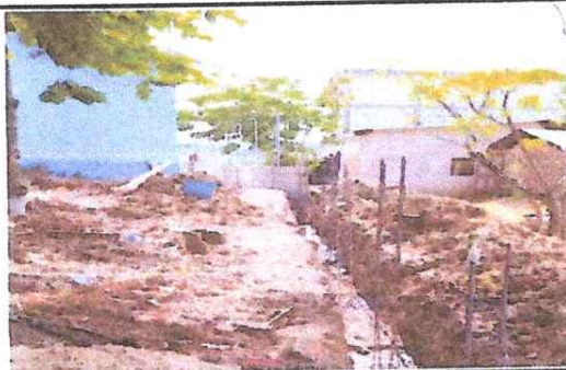
Foto 5: Continuación de fundición de columnas y de solera de humedad.
