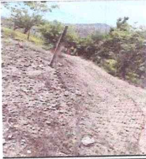
Foto 3: Lado derecho a trabajar con block, tubo y malla.
