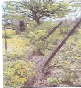
Foto 2: Parte de atrás, se retirará el actual y se colocará tapial de block con tubo y malla.
