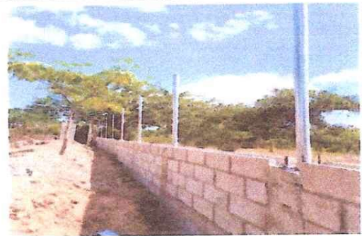
Foto 2: Levantado de Block y colocación de tubo galvanizado.
