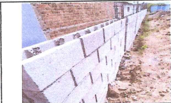
Foto 1: Lado izquierdo, muro perimetral levantado de Block.
