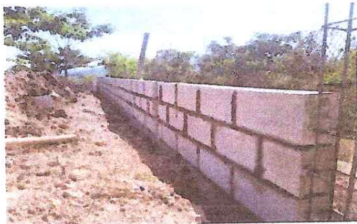
Foto 3: Lado derecho trabajando levantado de Block.
