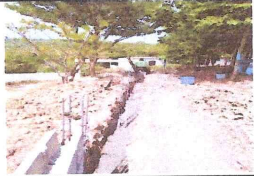
Foto 4: Fundición de columnas.
