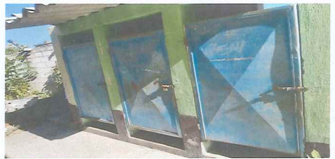
Foto 6: Cambio de Puertas
