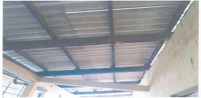
Foto 2: Cambio de techo
