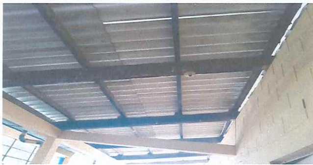
Foto 5: Cambio de Techo
