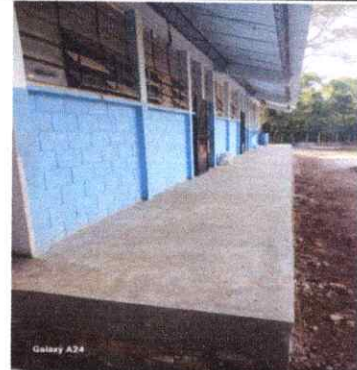
Foto 10: REPARACIÓN DE PISO DE TORTA DE CONCRETO
