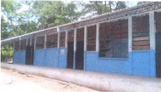
Foto 11: SUSTITUCIÓN DE VIDRIOS
