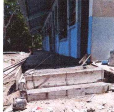
Foto 8: REPARACIÓN DE PISO DE TORTA DE CONCRETO
