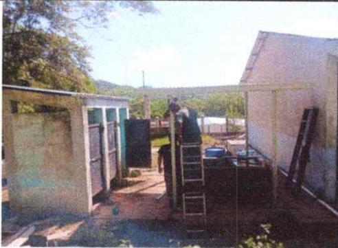
Foto 5: INSTALACIÓN DE TECHO Y MEJORAMIENTO EN PILA DE UN LAVADERO
