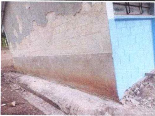
Foto 9: REPARACIÓN DE PISO DE TORTA DE CONCRETO
