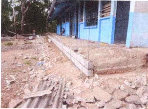
Foto 7: REPARACIÓN DE PISO DE TORTA DE CONCRETO
