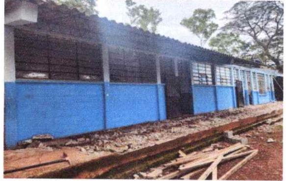
Foto 2: SUSTITUCIÓN TECHO CON DURALITA Y ESTRUCTURA DE METAL POR LÁMINA TROQUELADA EN MODULO DE AULAS
