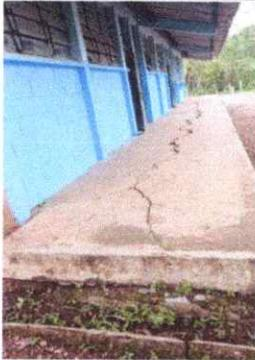
Foto 7: REPARACIÓN DE PISO DE TORTA DE CONCRETO
