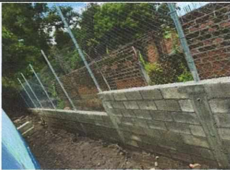
Foto 11: REPARACIÓN Y MEJORAMIENTO DE MURO PERIMETRAL
