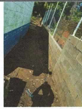
Foto 10: REPARACIÓN Y MEJORAMIENTO DE MURO PERIMETRAL
