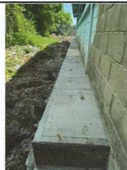
Foto 6: REPARACIÓN DE TORTA DE CONCRETO
