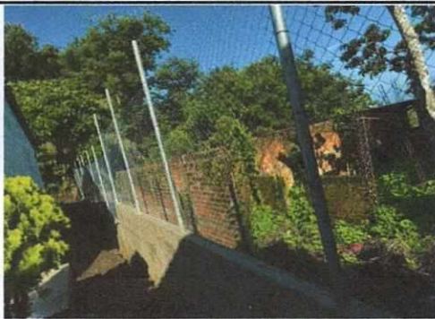
Foto 9: REPARACIÓN Y MEJORAMIENTO DE MURO PERIMETRAL
