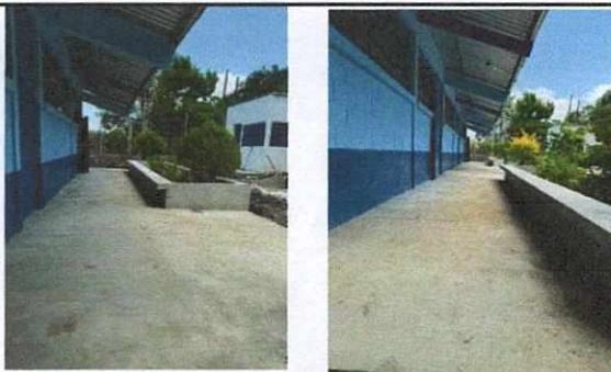
Foto 5: REPARACIÓN DE TORTA DE CONCRETO
