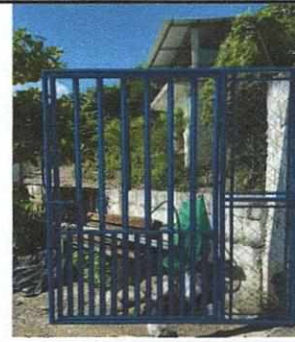
Foto 12: MEJORAMIENTO DE PORTÓN PRINCIPAL
