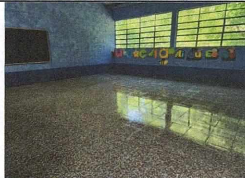
Foto 4: SUSTITUCIÓN DE PISO DE CONCRETO POR PISO DE GRANITO
