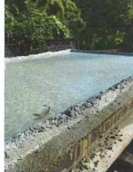
Foto 8: MEJORAMIENTO DE SERVICIOS SANITARIOS
