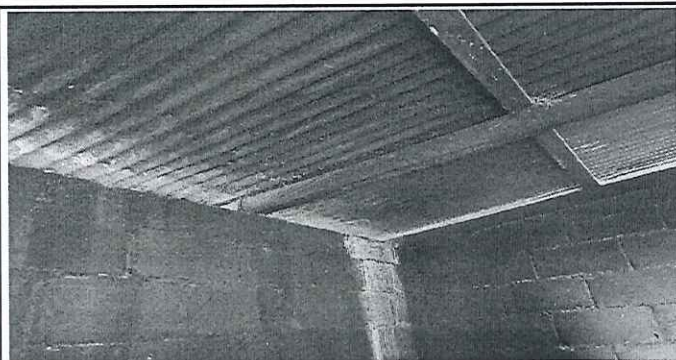
TECHO DE CICINA EN MALAS CONDICIONES SE NECESITA CAMBIO DE ESTRUCTURA Y LAMINA
