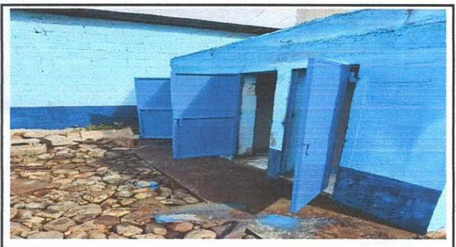
Foto 3 Reparacion de baños
