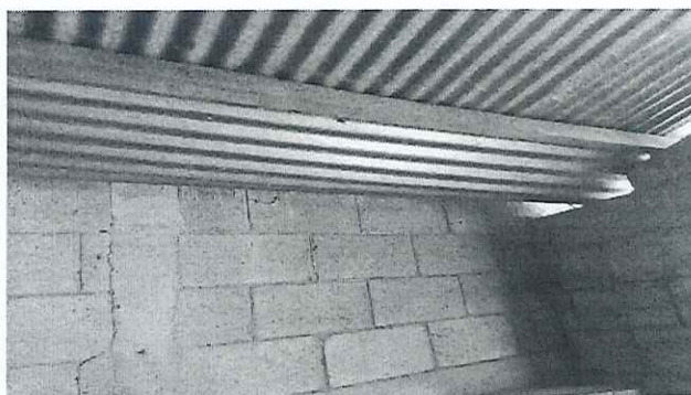
Foto 2: Cambio de techo de cocina
