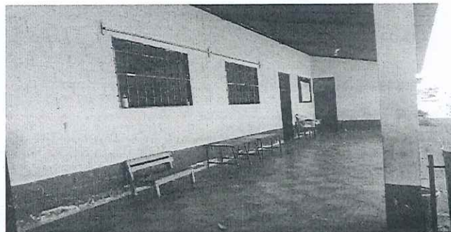
Foto 6: Cambio de Piso
