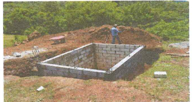
FOTO 4 Mejoramiento de fosa séptica
