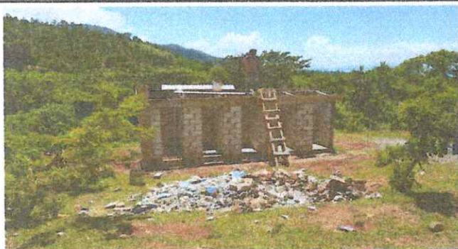
FOTO 5 Mejoramiento y cambio de baños sanitarios
