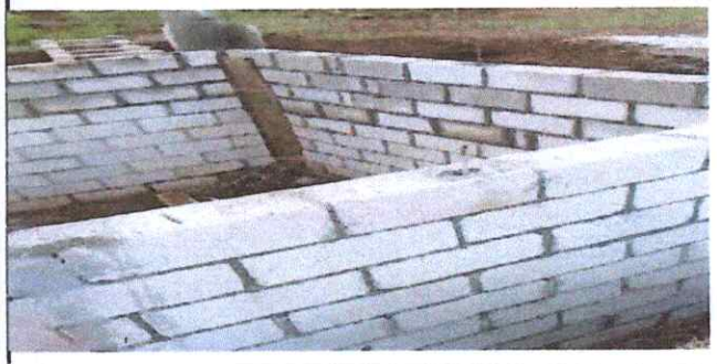
Foto 2: Levantado de fosa séptica
