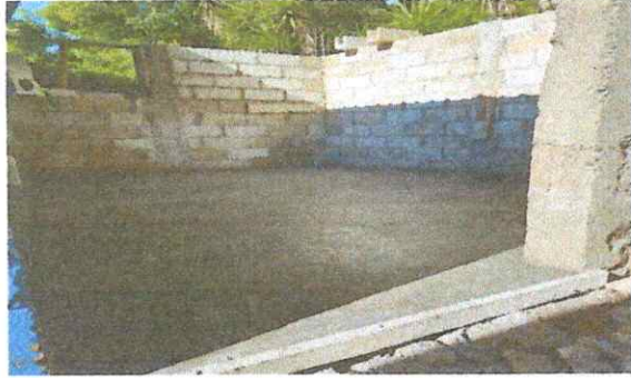
FOTO 1 Levantado de muro
