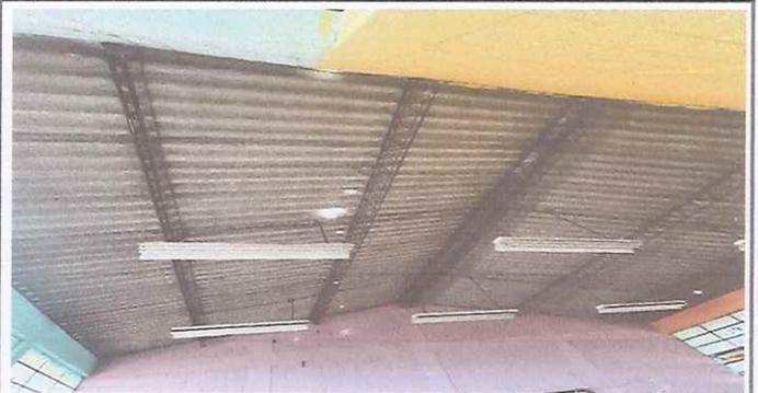
Fotografía 4: Techo del modulo 2 en malas condiciones.
