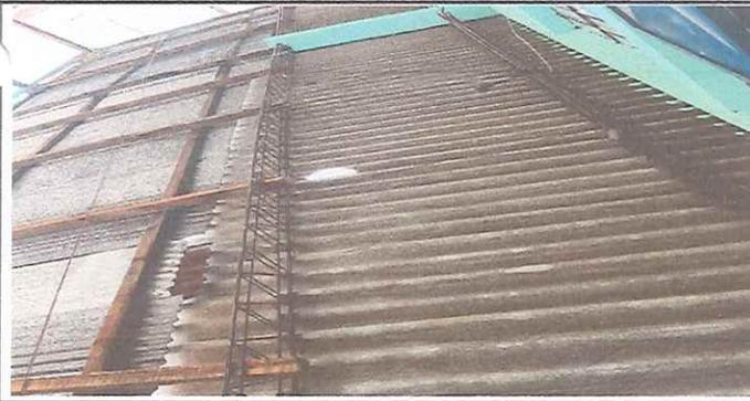
Fotografía 5: Cambio del techo del corredor en malas condiciones.
