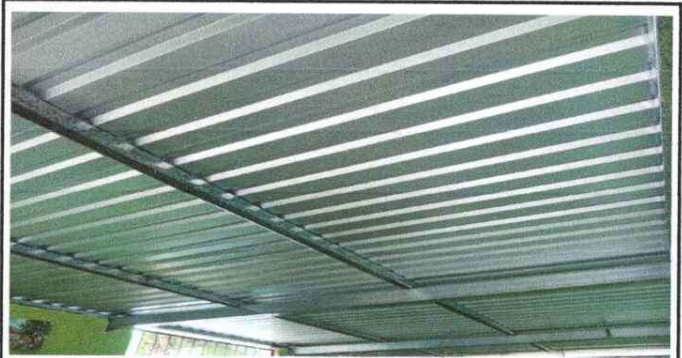
FOTO 2: TECHADO DEL AULA
