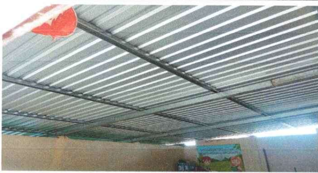
FOTO 1: TECHADO DEL AULA
