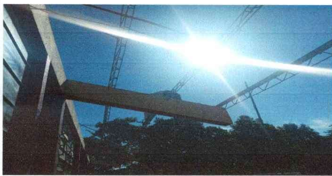
FOTO 3: SUSTITUCIÓN DE DURALITA POR LÁMINA EN EL SALÓN
