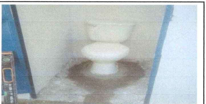
FOTO 6: SUSTITUCIÓN DE TAZAS DE BAÑO
