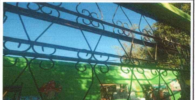
FOTO 4: SUSTITUCIÓN DE LÁMINA Y MADERA DE AULA 3
