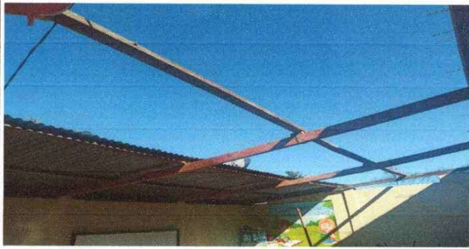
FOTO 1 SUSTITUCIÓN DE LÁMINA Y MADERA DE AULA 1
