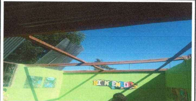
FOTO 2: SUSTITUCIÓN DE LÁMINA Y MADERA DE AULA 2
