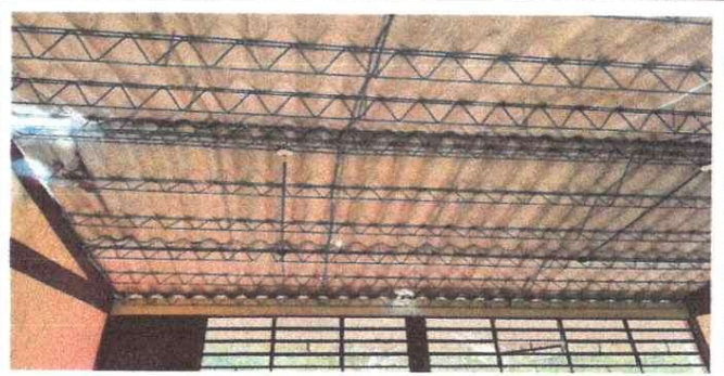
Foto 2: Mejoramiento y colocacion de techado en aula
