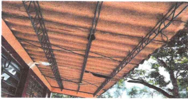
Foto 1: Mejoramiento y colocacion de techado en aula
