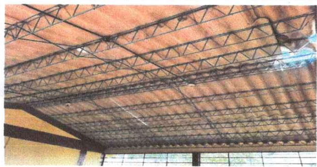
Foto 3: Mejoramiento y colocacion de techado en aula
