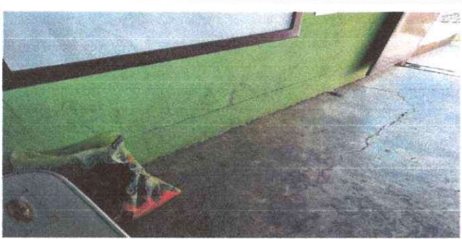
Foto 5: Remozamiento de un aula
