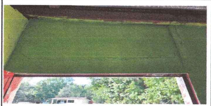
Foto 4: Remozamiento de un aula
