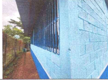
Foto 2: Mejoramiento de pintura exterior.
