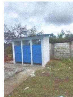
Foto 6: Mejoramiento de baños.
