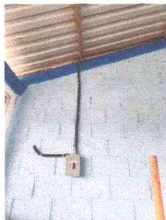
Foto 5: Mejoramiento de sistema electrico en aulas.
