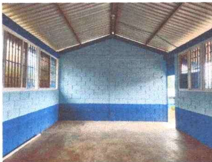
Foto 3: Mejoramiento de pintura interior.
