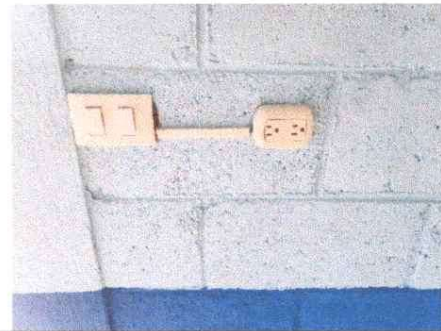
Foto 4: Mejora de sistema electrico en aulas.
