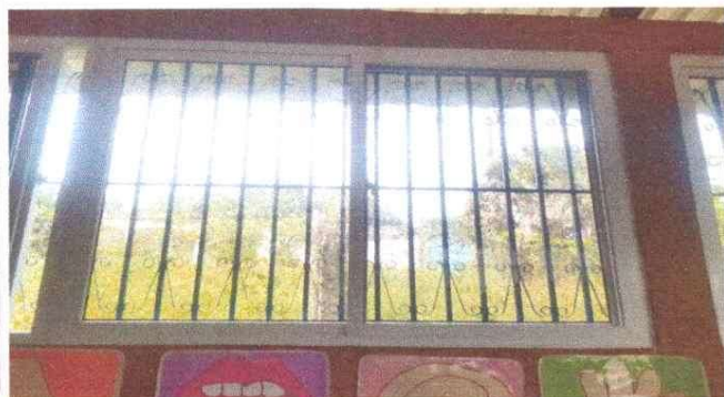
Foto 3: Instalacion de ventanas de pvc color blanco, corredizas, vidrio bronce claro, y cedazo para mosquitero.
