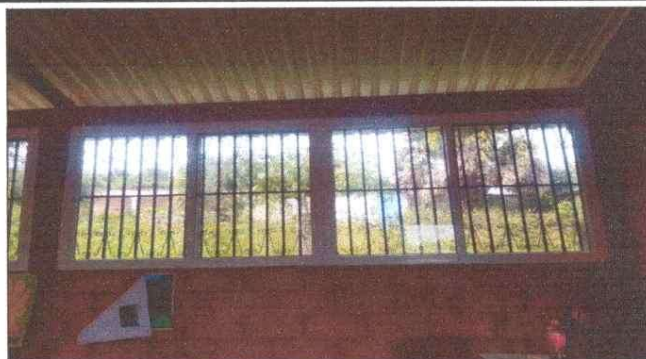
Foto 2: Instalacion de ventanas de pvc color blanco, corredizas, vidrio bronce claro, y cedazo para mosquitero
