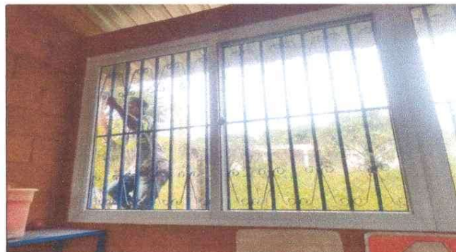
Foto 4: Ventanas de pvc, selladas y aseguradas con material de calidad, contiene hoja de mosquitero para mejor claridad y ventilacion.
