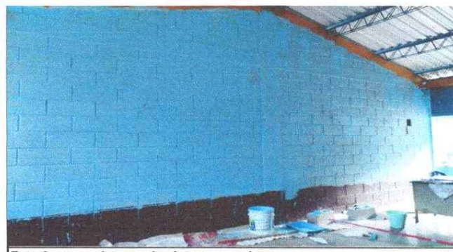
Foto 6: segunda capa de pintura gama latex
